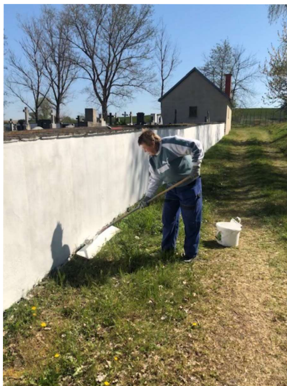
Oprava hřbitovních zdí
