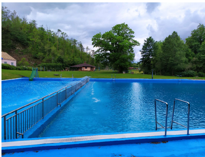
Koupaliště připravené k provozu
