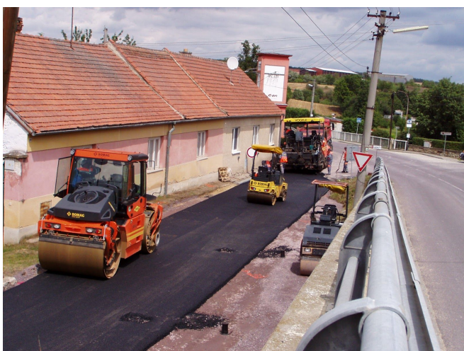
Oprava silnice U Trafa
