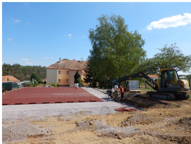
Budování hřiště na školní zahradě
