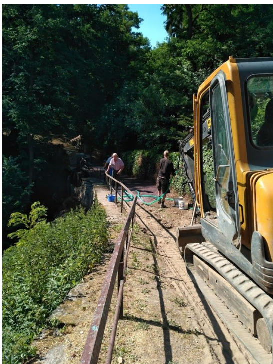
Oprava zídky pod kostelem
