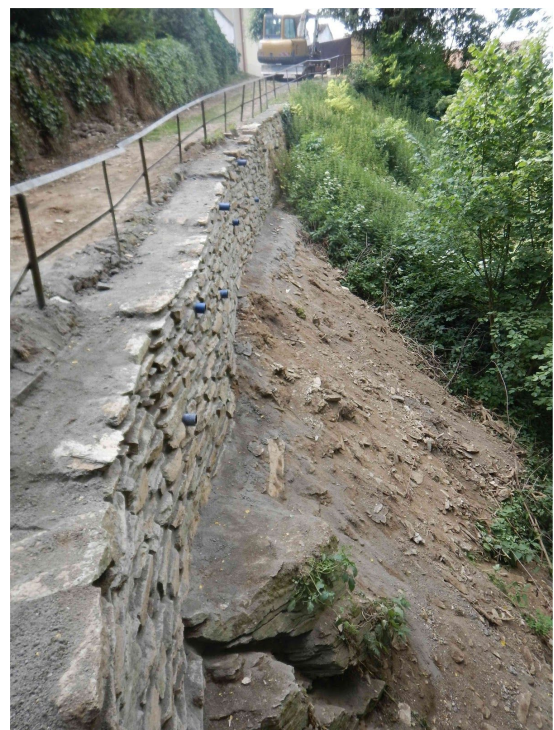
Oprava zídky pod kostelem
