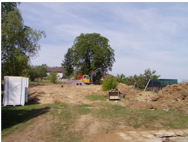
Budování hřiště na školní zahradě
