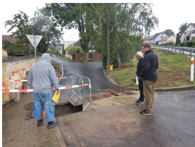
Oprava silnice Za Rybníky
